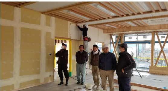
【新事務所工事状況の視察】
