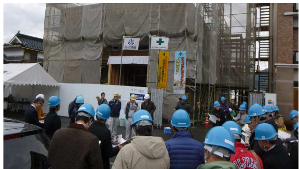
【CLT建築現場】
