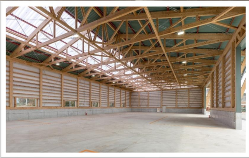
木造製品倉庫加工棟
